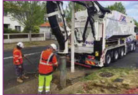
Enfouissement rue Louis de Foix à BAYONNE
